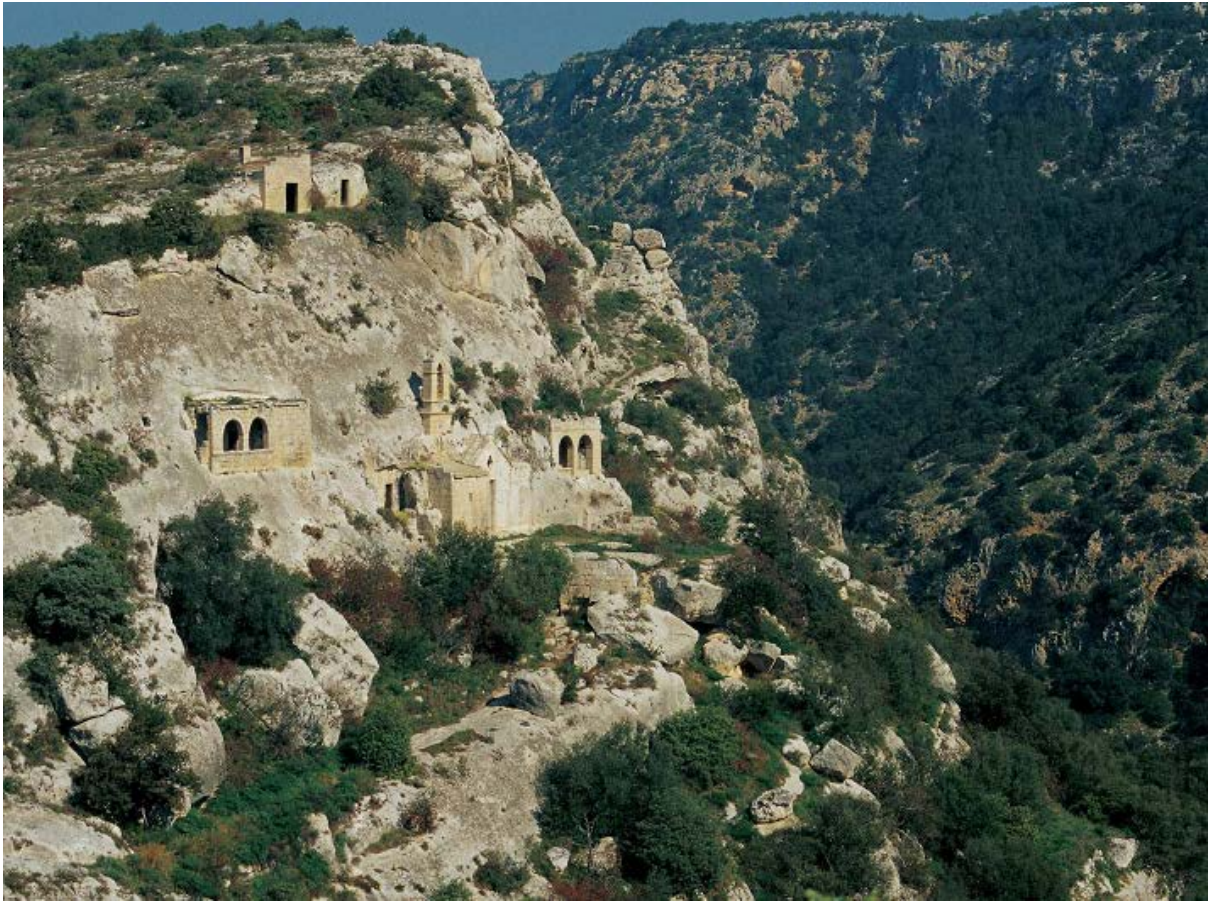
La chiesetta rupestre di Cristo la Selva, lungo un costone della Gravina, a 6 km a sud di Matera.
